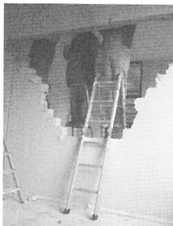
So, jetzt steht die Leiter besser!
